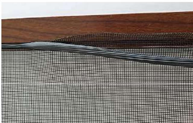
**5.** Finir de fixer et tendre la toile sur le dernier angle avec le joint. Puis découper, le reste de toile dépassant (tout en laissant dépasser 1 à 2cm de toile).
